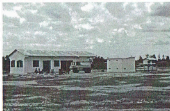
Ejeda, Schreinerwerkstatt und Solaranlage (Fotos: Re. O.)
