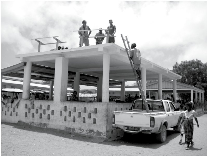
Montage der Solarpanels in St. Augustin
