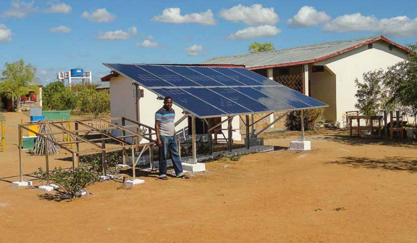
Dank SolarSpar funktioniert die Solaranlage im Zentrum Ejeda wieder einwandfrei. Der Dieselgenerator kann eingemottet werden.
