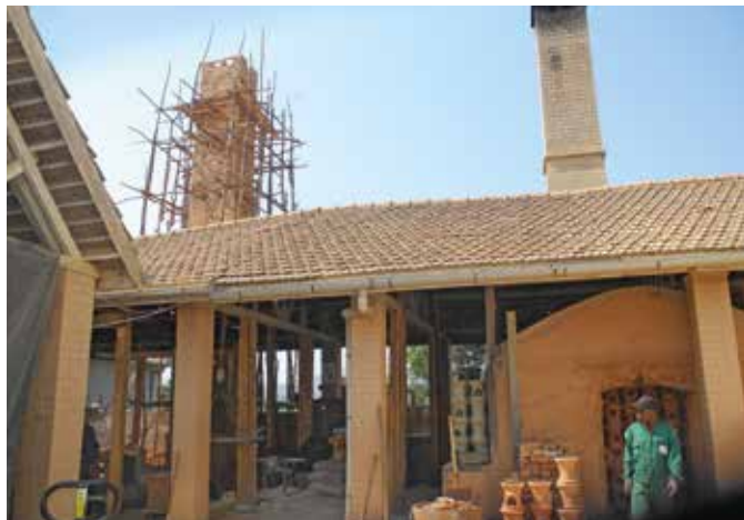
Le nouveau haut fourneau est bientôt terminé
