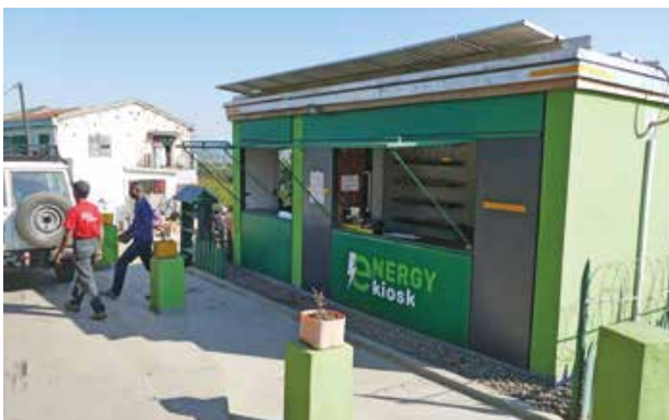
Energy-Kiosk von HERi
