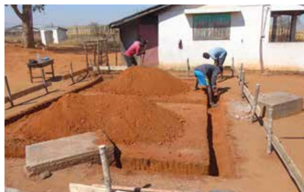
La construction d'une nouvelle cuisine scolaire commence
