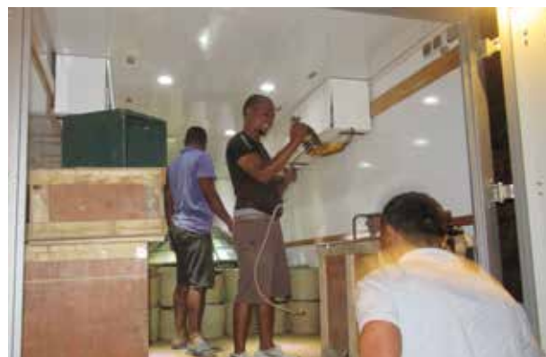
L'intérieur de l'antenne mobile nord est aménagé.
