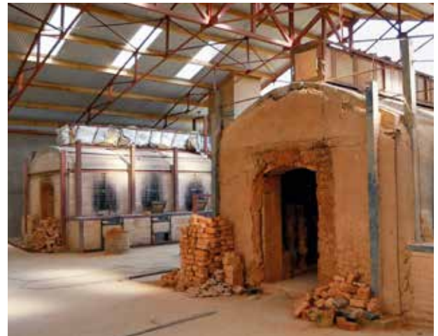
Le nouveau four de cuisson (derrière) est relié à l'ancien par un sous-terrain.
