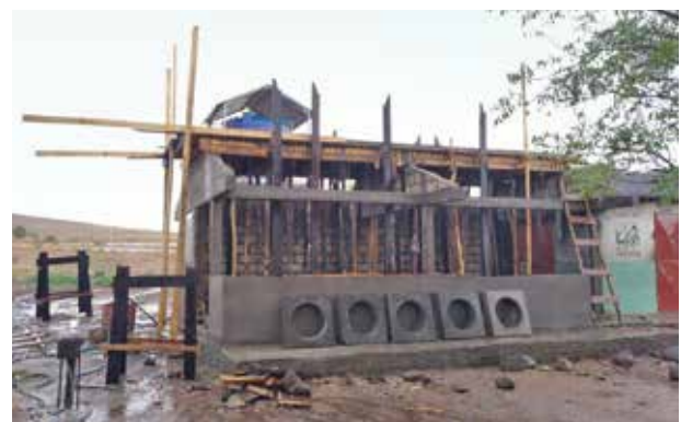
Construction de la nouvelle cuisine de cantine.
