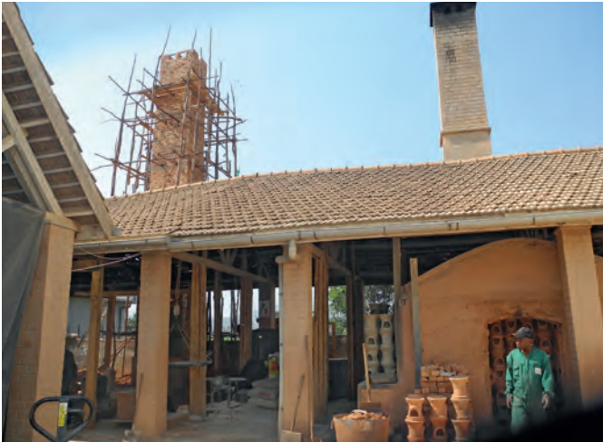
Der neue Hochofen kurz vor der Fertigstellung
