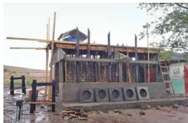
Bau der neuen Grossküche.
