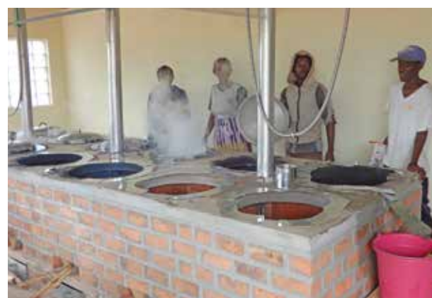
Optimierte Kochstelle nach dem Umbau.
