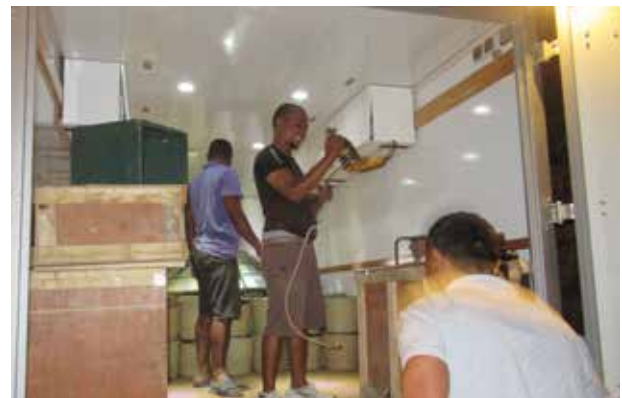
Das ADES Mobil Nord wird innen ausgebaut.
