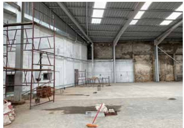
Ende Januar 2022 steht der Bau vor der Fertigstellung.
