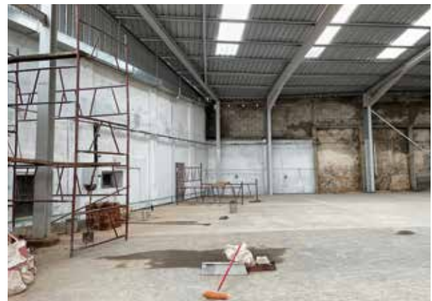
A fin janvier 2022, le bâtiment est en phase d'achèvement.
